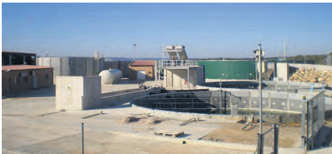
La planta de tratamiento de purines y otros cosustratos de Valderrobres nunca ha llegado ponerse en funcionamiento. NDM
