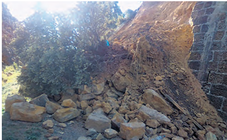
La Vía Verde sufrió muchos daños debido a la borrasca Gloria. NDM
