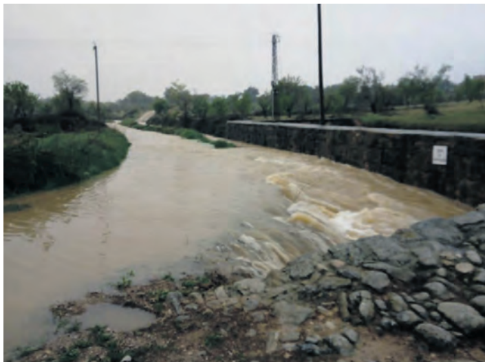
Las obras pretenden que el agua pase por encima en lugar de por debajo. NDM
