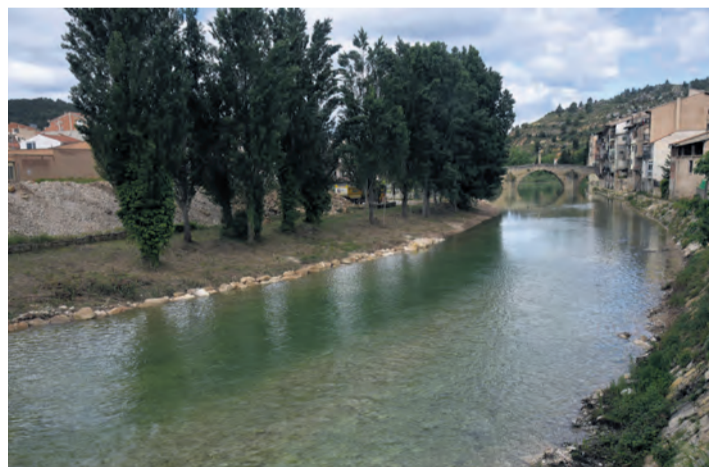
La limpieza del río era necesaria tras las gravas dejadas por las riadas. JP
