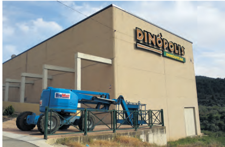
Las obras de rehabilitación de Inhóspitak están a punto de finalizar. MJG
