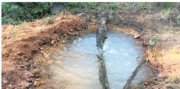
Por el agujero de la tubería manaba una gran cantidad de agua. NDM
