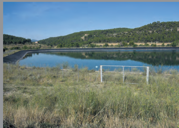
En el plan se están georreferenciando las balsas antiincendios. NDM
