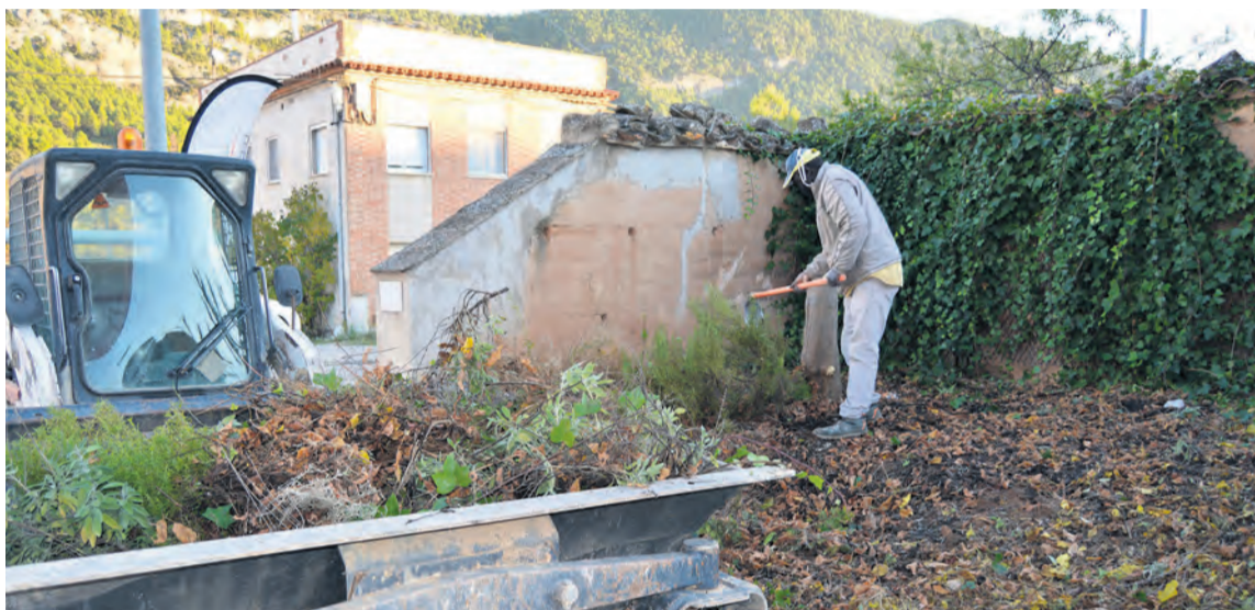
El punto de recarga para coches eléctricos de Fuentespalda se ubicará junto al edificio del Cubic. MJG
