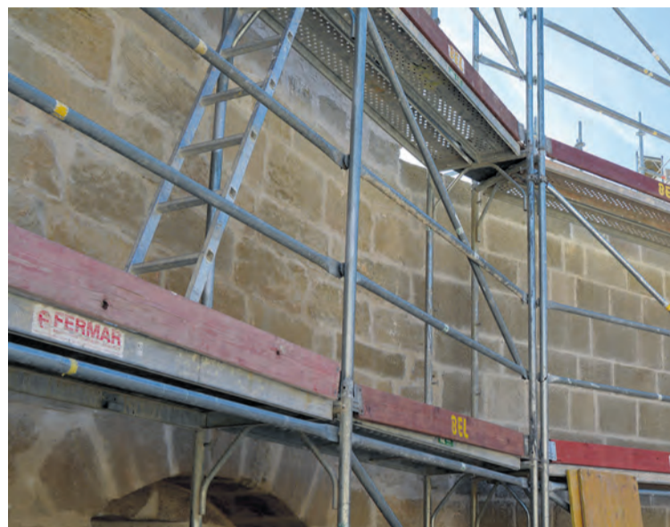
Los trabajos de rehabilitación continúan en el Castillo de Valderrobres. MJG
