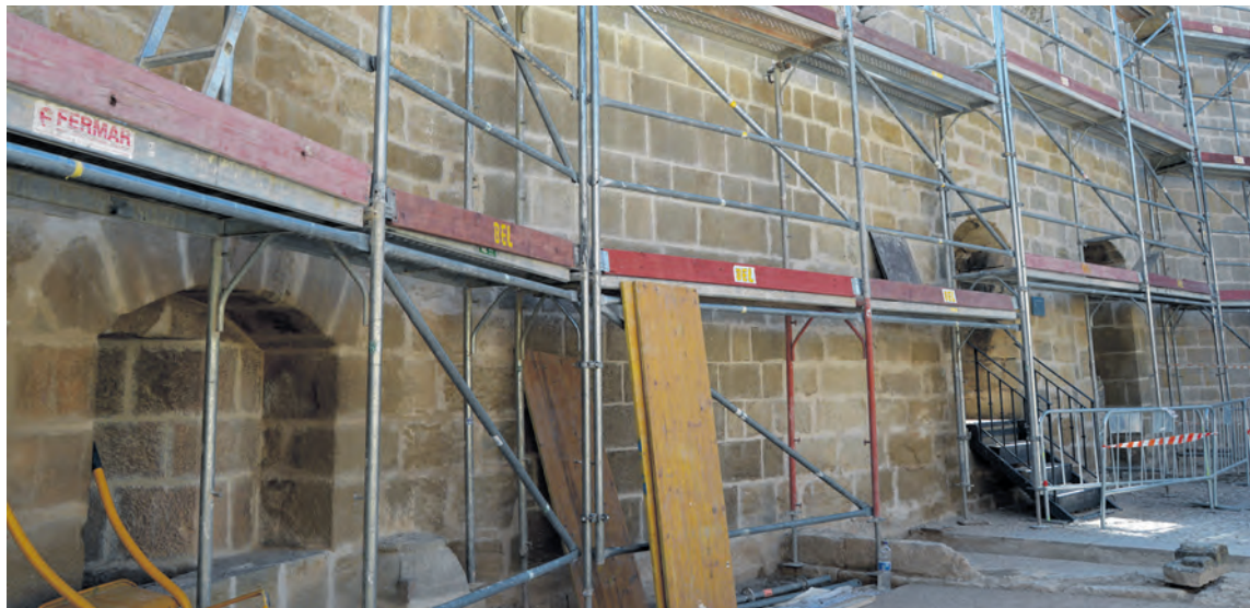
Las obras de restauración del Castillo siguen desvelando nuevos detalles de su construcción e historia. MJG
