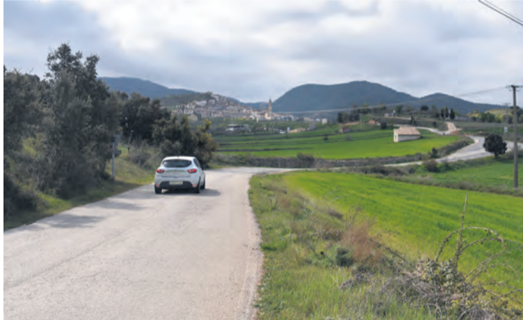
La actual carretera supone un peligro para los conductores.. MJG
