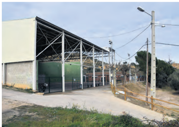
Se ha actuado sobre el muro lateral y el pavimento del escenario. RL
