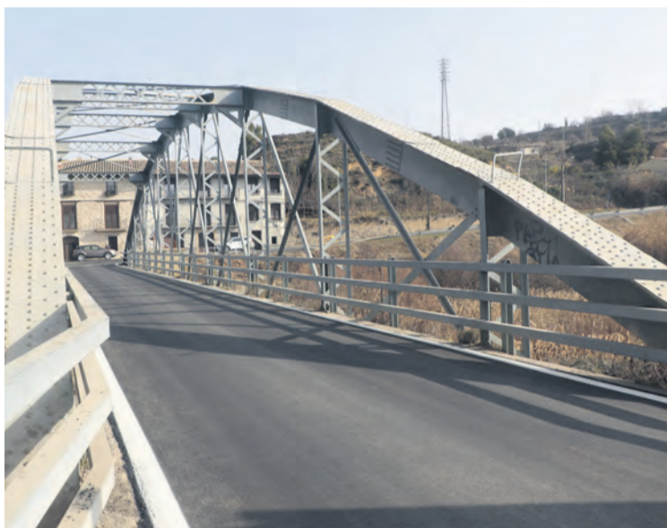
El puente ya luce un asfaltado totalmente renovado. IA
