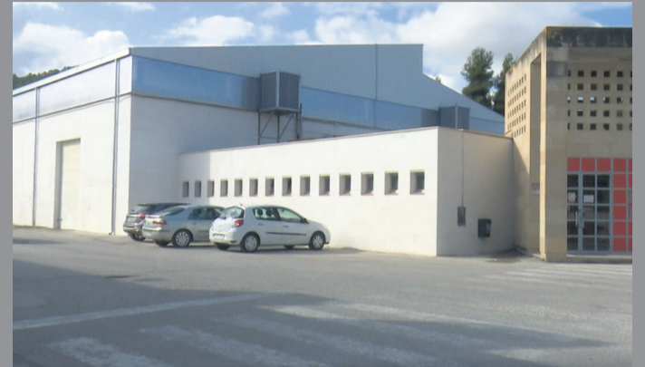
La actuación principal se ha centrado en rehabilitar la cubierta. IA
