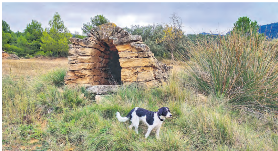
Un pozo-fuente desarrollado en 'pedra en sec' y ubicado en la partida de los Prats de Peñarroya de Tastavins. R. L.
