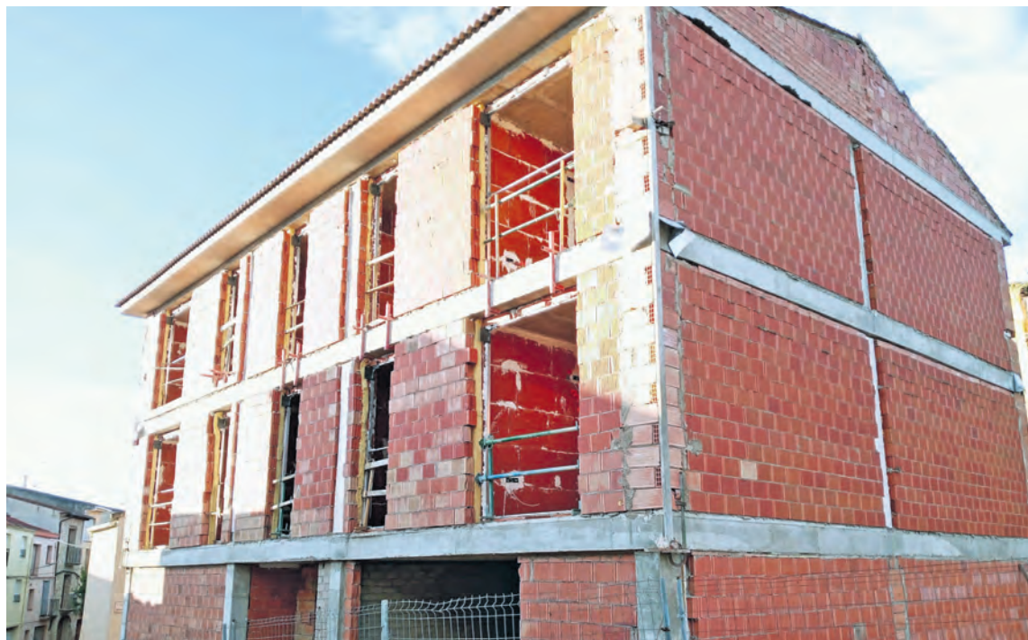
Valjunquera está levantando un bloque de cuatro viviendas como respuesta al déficit residencial de su pueblo. R. L.
