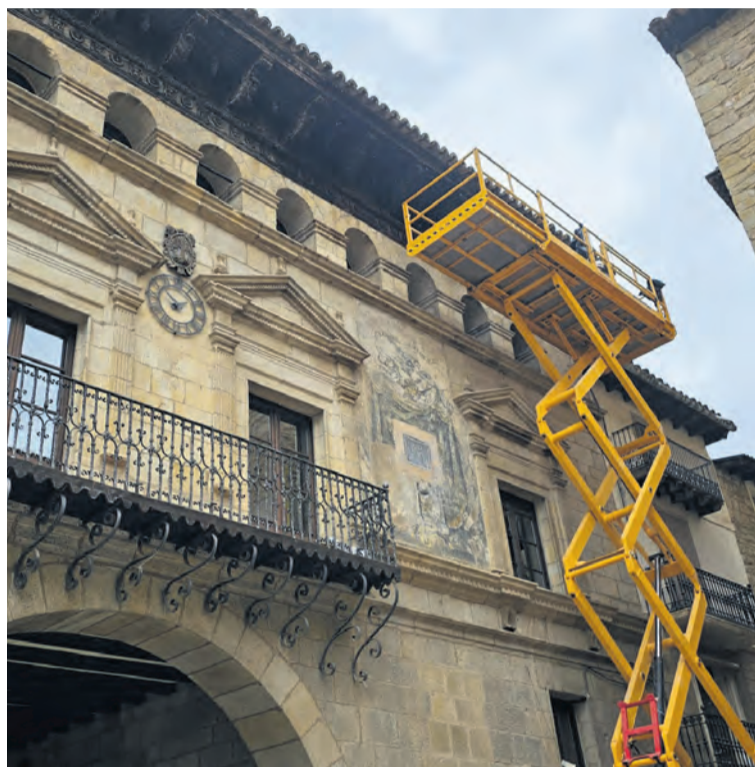
La actuación ha empezado por el lateral de la calle La Paz. M. Jiménez
