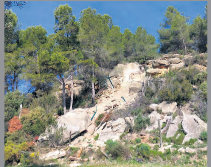
El abrigo que escondía las pinturas rupestres ha colapsado. NDM
