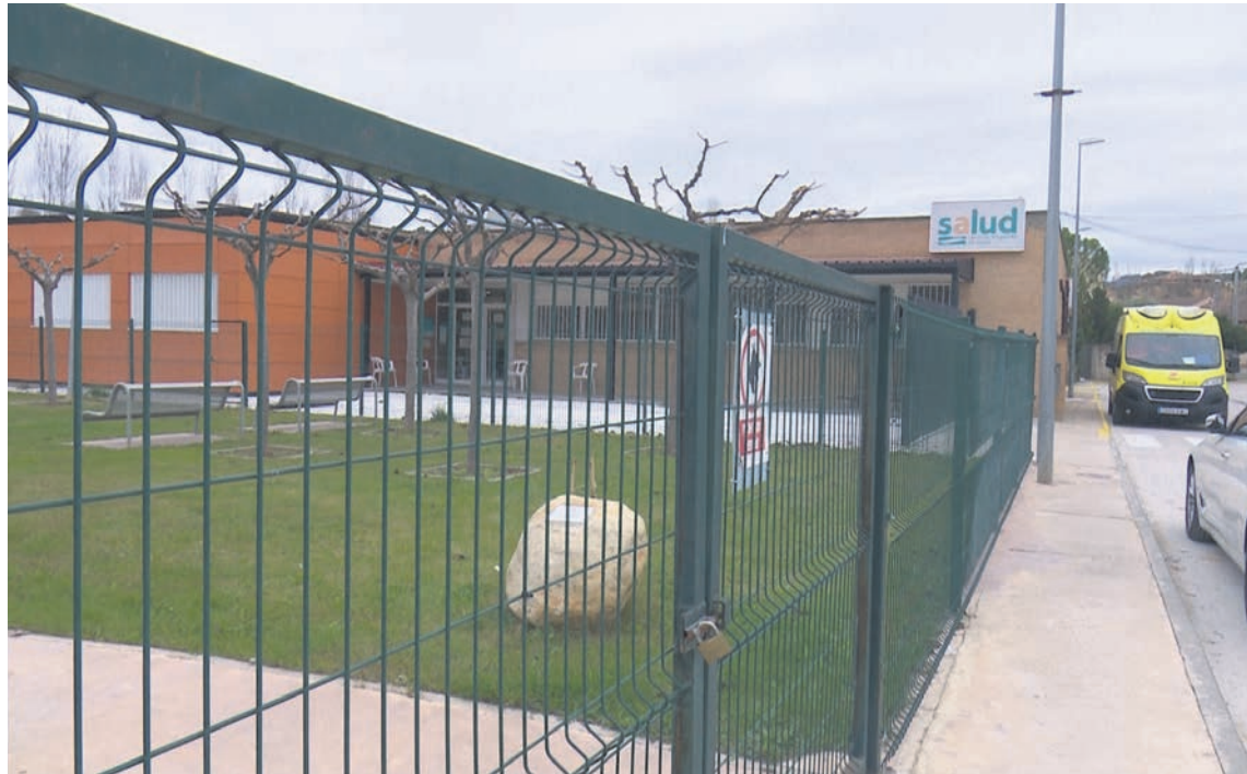
El Centro de Salud de Valderrobres fue uno de los servicios más afectados por la falta de luz. NDM
