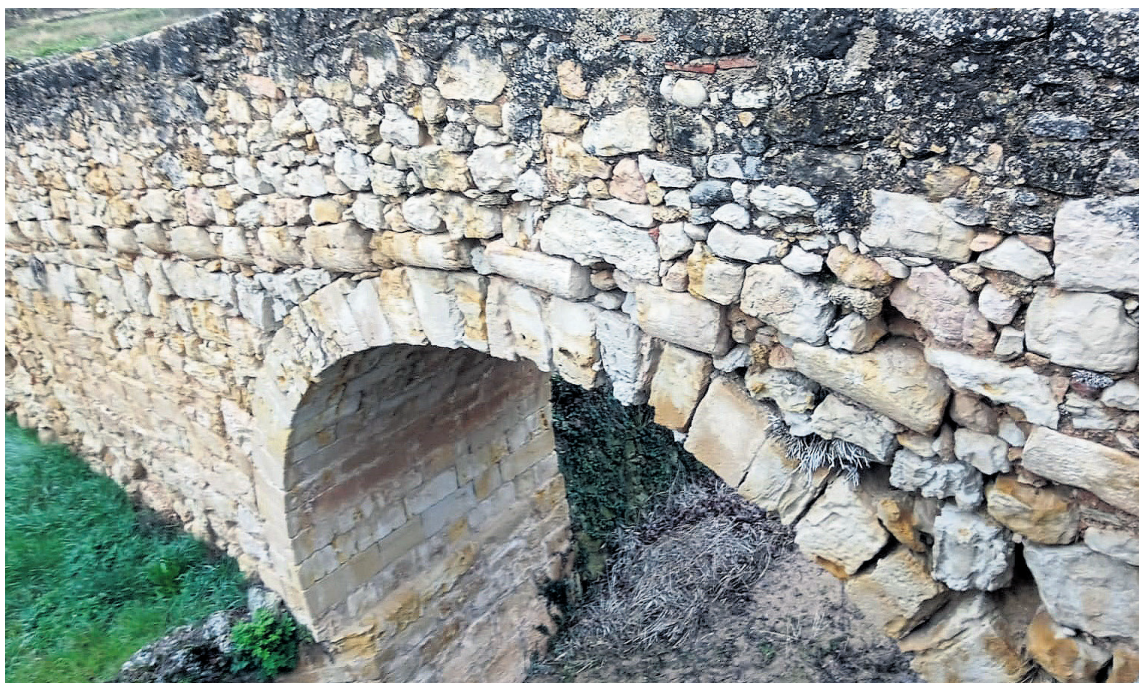
Fotografía del puente de Torre de Arcas, con algunos sillares del único ojo donde se aprecia la enfermedad. NDM
